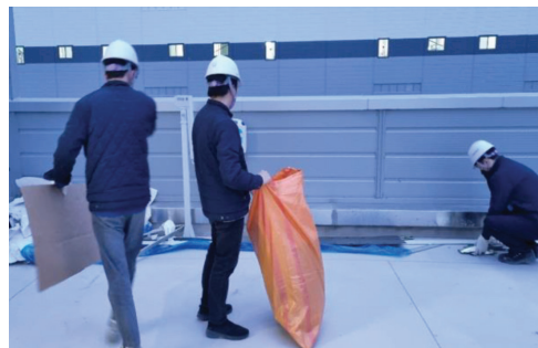
공사 자재 보관 상태 점검 및 조치
